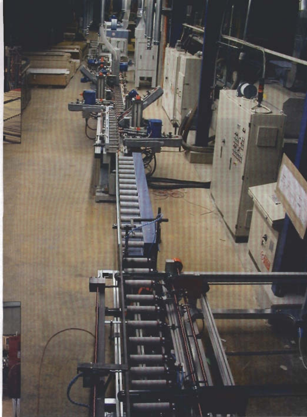
Die im Januar dieses Jahres in Betrieb genommene neue Ummantelungs-, Schleif- und Lackieranlage
