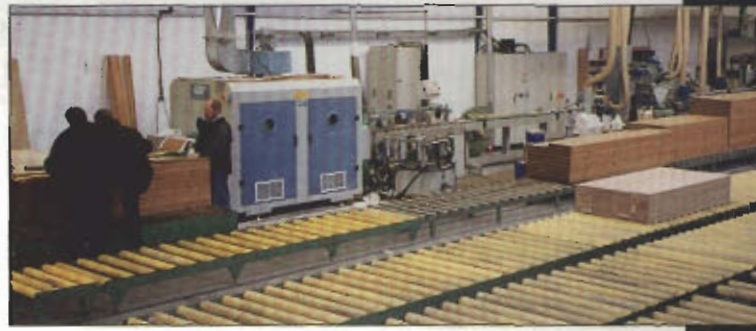
Die im Jahr 1999 in Betrieb genommene Oberflächenap- plikationsanlage für Bekleidungs- elemente
